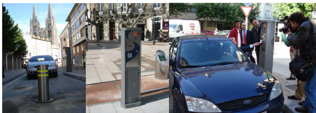
図 3(2)-2 IC カードによる自動昇降ボラード
